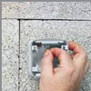
1/ Otvor urobíte zatlačením pomocou zakončovacieho nástroja
