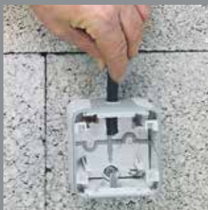
2/ Prestrčte kábel cez priechodku
