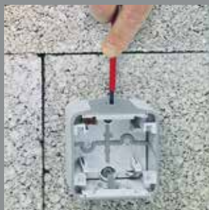
1/ Prepichnete membránu pomocou skrutkovača
